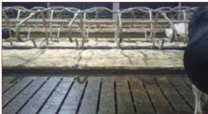
**Figura 2.** Enrejillados cubiertos con material plástico
