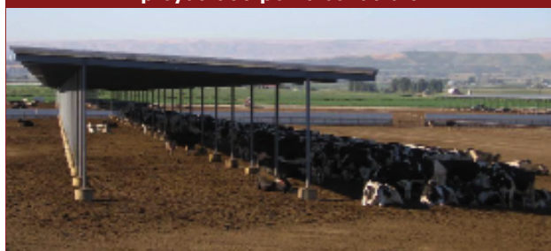
Figura 9. Las vacas se desplazan con la sombra proyectada por la estructura
