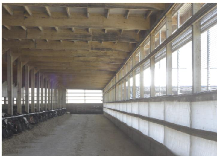
Fotografía 7. Vista interior de la pared lateral de entrada de aire. Dispone de dos líneas de microdifusores
