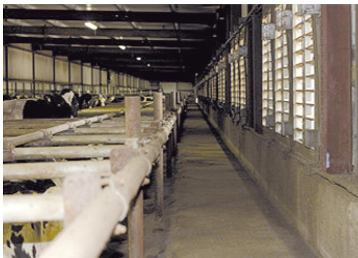
Fotografía 6. Pasillo lateral para permitir el acceso a los ventiladores
