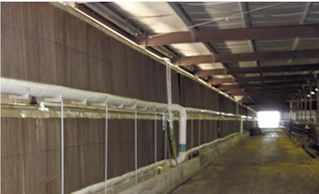
Fotografía 4. Vista interior de pared lateral de entrada de aire compuesta por paneles evaporatorios
